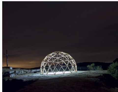
Thomas Lasbouygues, Radôme à palabre , 2016, Rocher de la Baume (FR). Dôme géodésique en bois Douglas, nœuds en PVC renforcé, diodes électroluminescentes. ø 600 × 400 cm. Menuiserie : Christophe Issaly.
